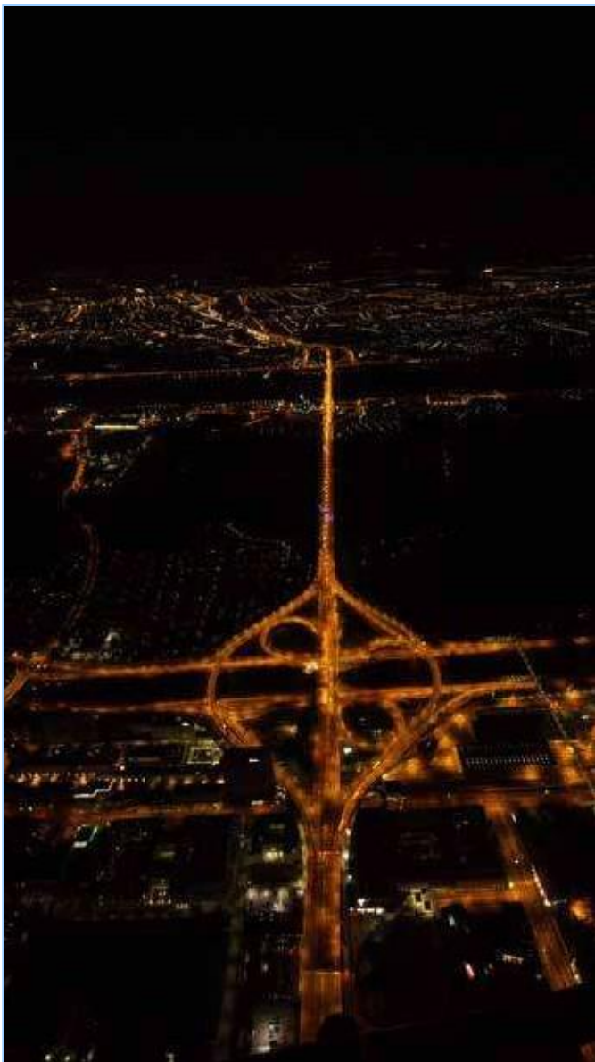
Abb. 39: Stadtautobahnen: Autobahnkreuz A23/A4 am 22. April 2016. Natriumdampf-Lampen waren hier das ausschließlich verwendete Leuchtmittel.
