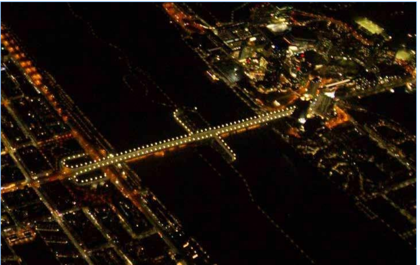
Abb. 30: Die Reichsbrücke im Februar 2023. Die neue Wiener Kugel bestrahlt die Fahrbahn ebenso wie die darüber liegende Hemisphäre mit LED-Lampen weiß (das Bild ist aufgrund besserer Aufnahme-Bedingungen schärfer als 2016).
